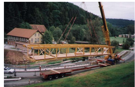
Brücke beim Einheben
