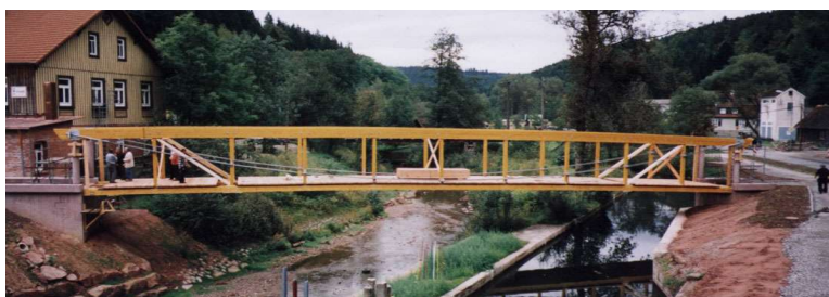
im Werk vorgefertigte Brücke nach dem Einheben
