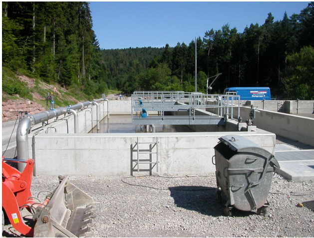
Nitrifikations- und Denitrifikationsbecken
