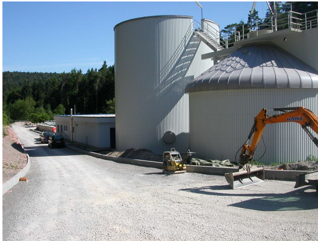
Betriebsgebäude mit Treppenturm und Faulbehälter
