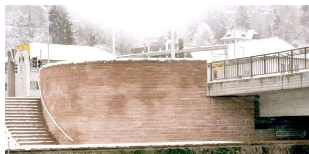
Detailansicht einer Bastion
