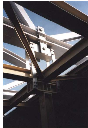
Detail Stahlhochhängung
