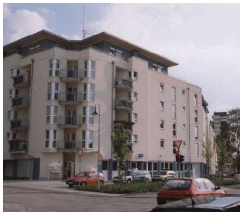
Ansicht von Nordosten
