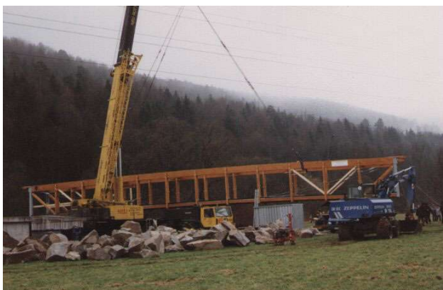
im Werk vorgefertigte Brücke beim Einheben
