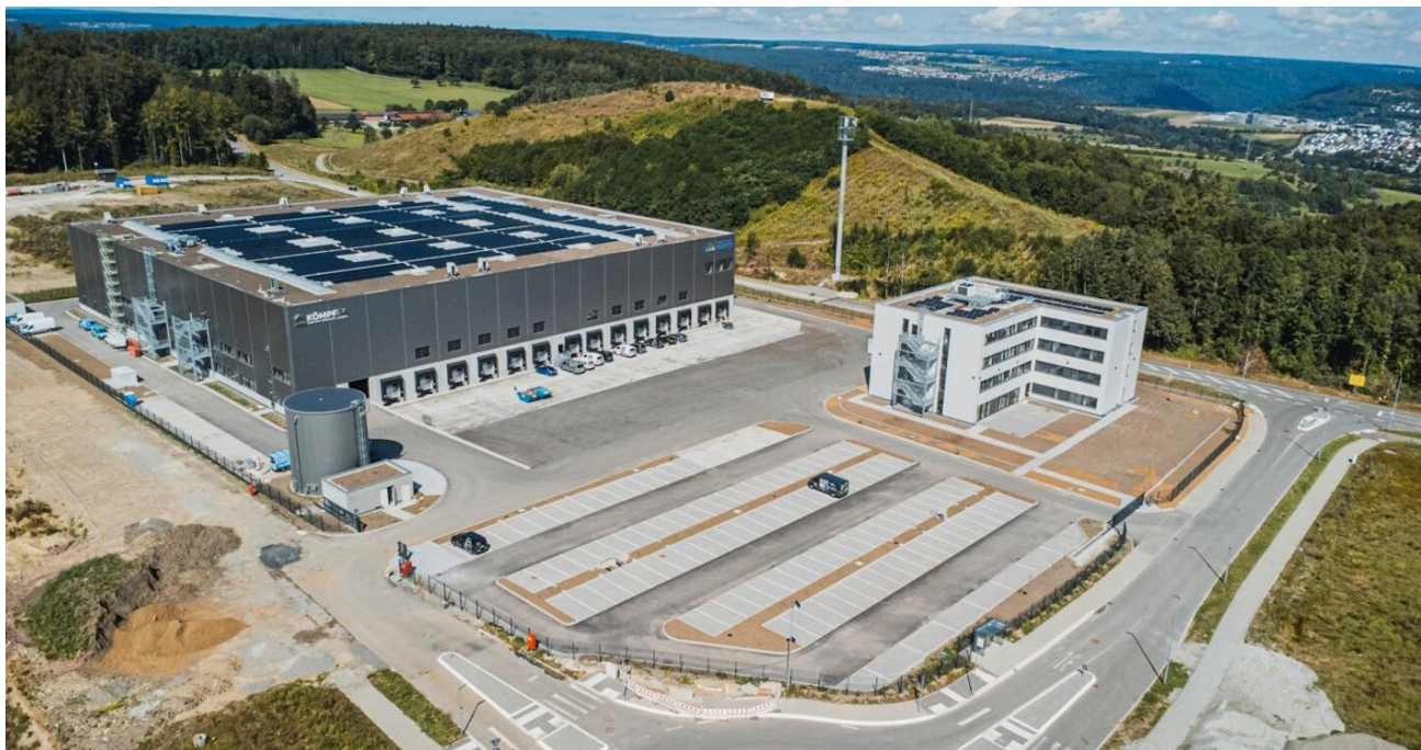
Ansicht neue Halle (links) und Bürogebäude rechts (© Kömpf)
