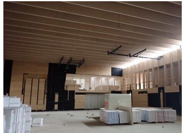
Innenansicht während der Bauphase
