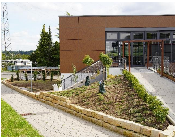
Rückansicht mit Rampe und Treppe
