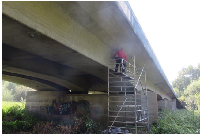
Untersuchungen am Brückenbauwerk
