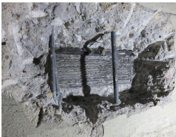
freigelegtes Spannlied in der Hohlkastenwand
