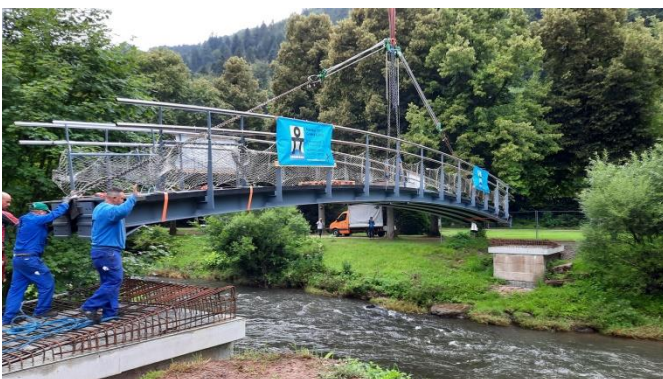
Einheben des Überbaus
