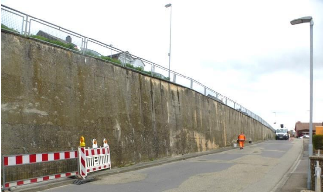
Ansicht einer geprüften Stützwand
