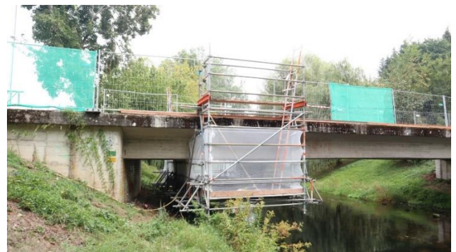
Hängegerüst mit Einhausung
