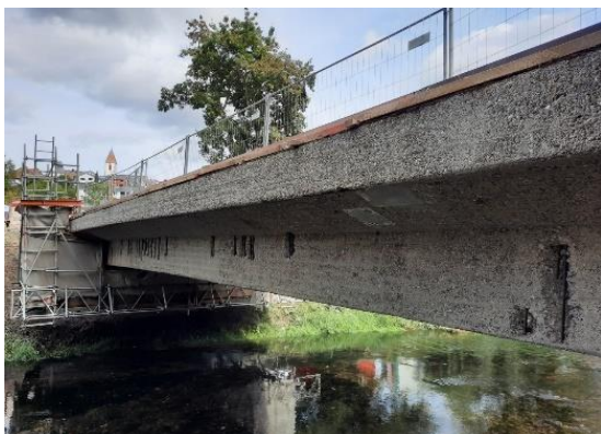
Schäden am Überbau während und nach der Instandsetzung
