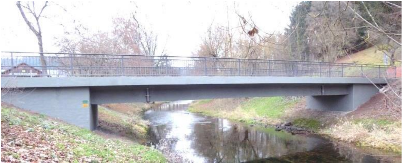
Ansicht Brückenbauwerk nach der Instandsetzung
