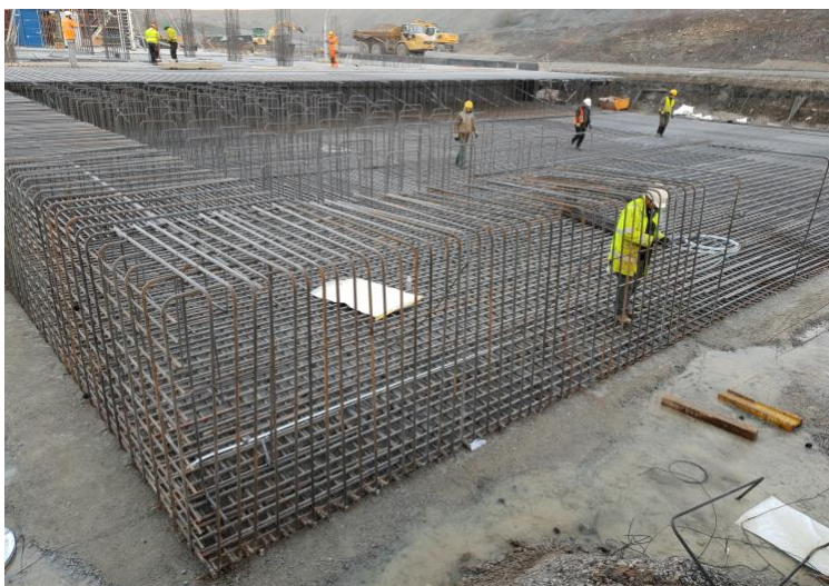
Bewehrung 2,0 m dicke Bodenplatte
