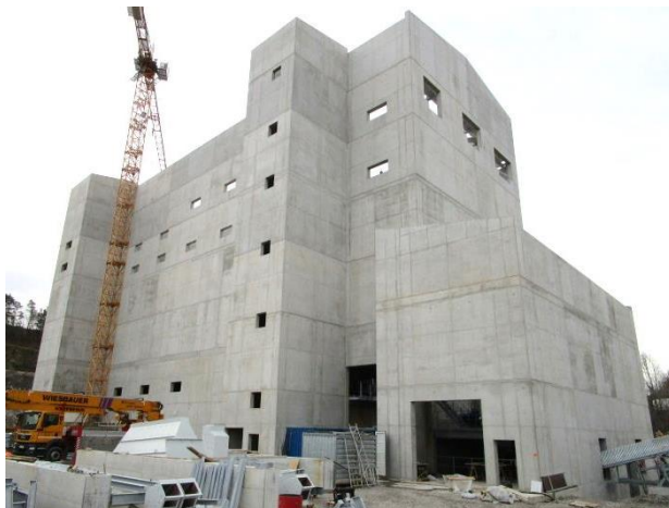
Außenansicht Rohbau Silogebäude
