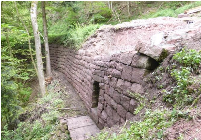
Auslauf Durchlass während der Instandsetzung
