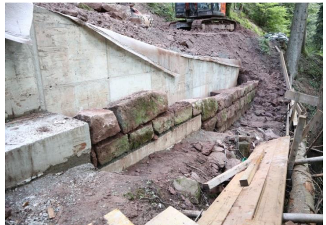
Wiederaufbau Natursteinmauer
