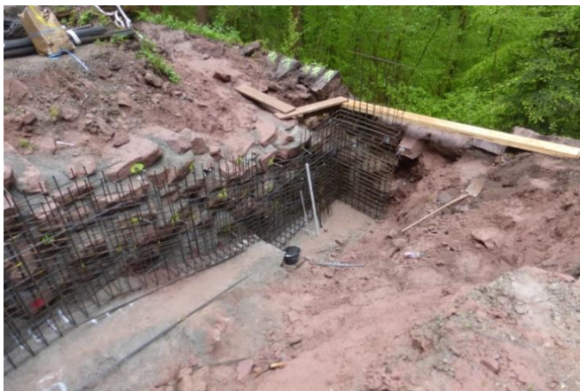
freigelegter Durchlass mit Wandbewehrung
