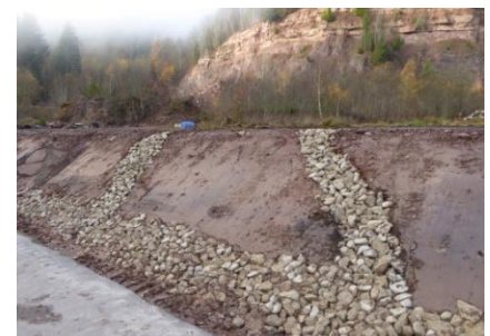
Befestigung Böschung
