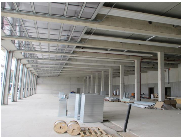
Innenansicht Fahrzeughalle (Bauphase)
