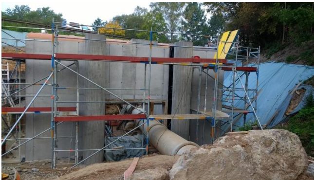
Auslassbauwerk im Bauzustand
