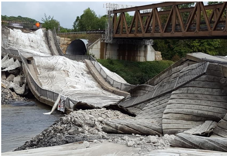
Bestandsbrücke direkt nach der Sprengung
