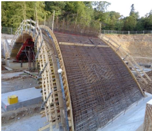
Bewehrung des Brückenbogens
