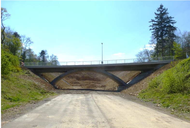
Ansicht Brücke während der Bauphase
