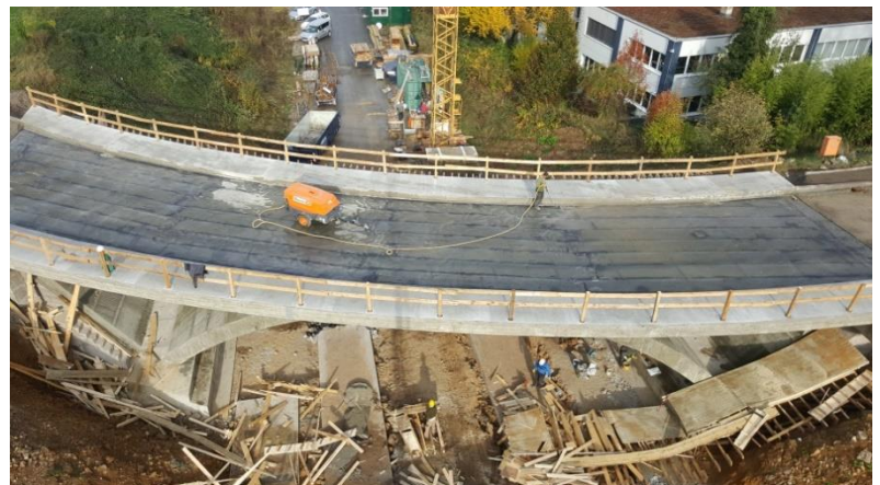
Aufbringen der Fahrbahnabdichtung
