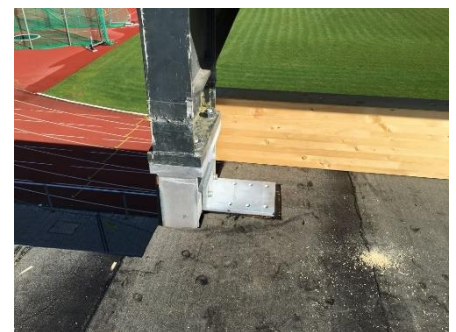
Befestigung Stahlvordach an neuer Dachdecke aus Holz
