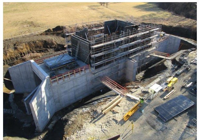
Gesamteindruck im Bauzustand
