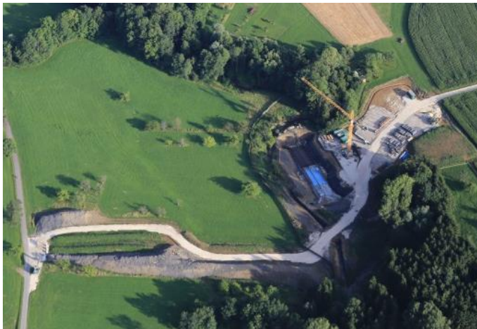
Luftaufnahme der Baumaßnahme
