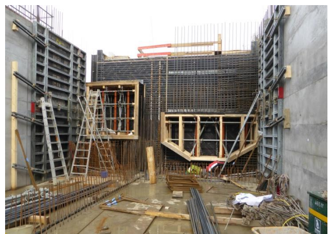
Wandbewehrung mit Durchbrüchen
