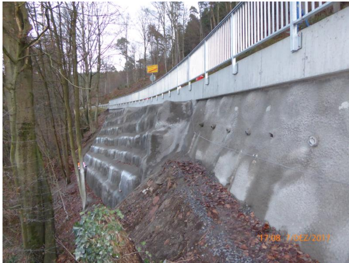
fertige Böschungssicherung
