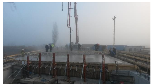
Glätten des frisch eingebrachten Betons
