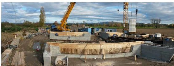
Widerlager mit Flügeln im Bauzustand
