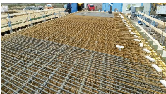
Bewehrung eines der Überbauten
