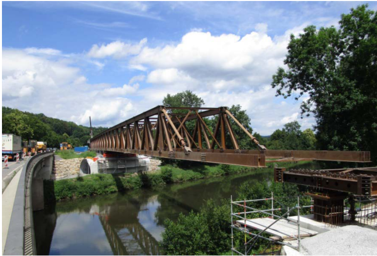
Behelfsbrücke während des Verschubs (links bestehende Brücke)
