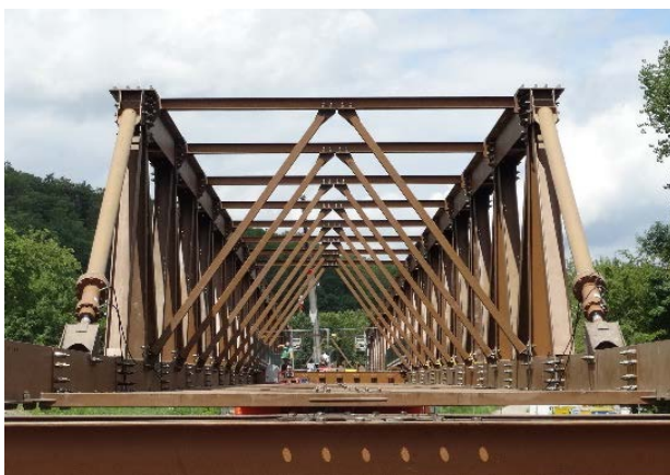
Vorbauträger während des Endverschubs
