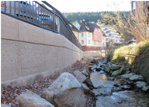
Ansicht fertige Stützwand
