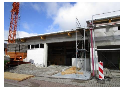
Ansicht von außen (Bauphase)
