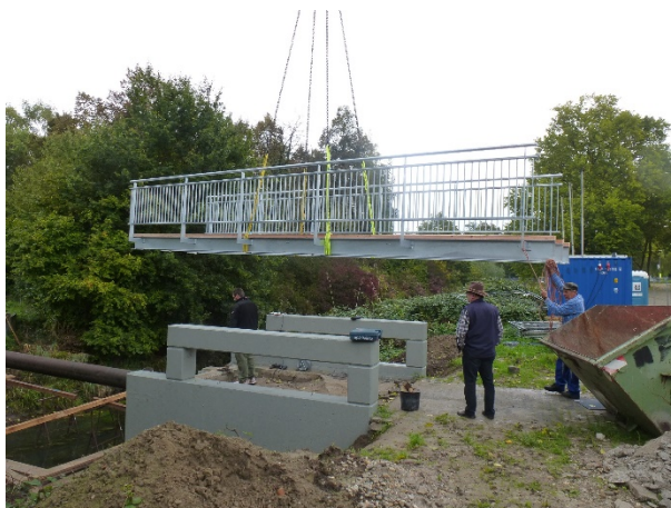
Einheben des komplett vorgefertigten Überbaus
