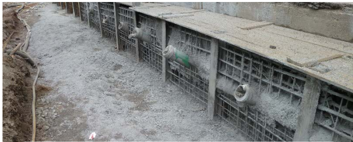
rückverhängte Spritzbetonwand im Bauzustand
