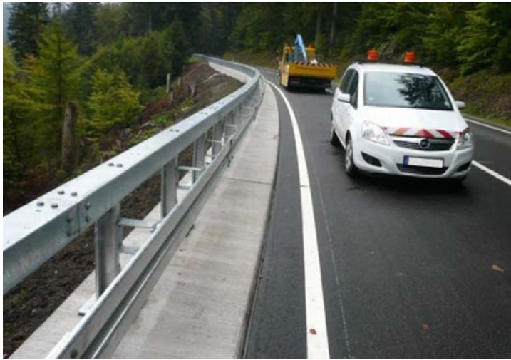
fertiges Bauwerk mit Gesims und Schutzeinrichtungen
