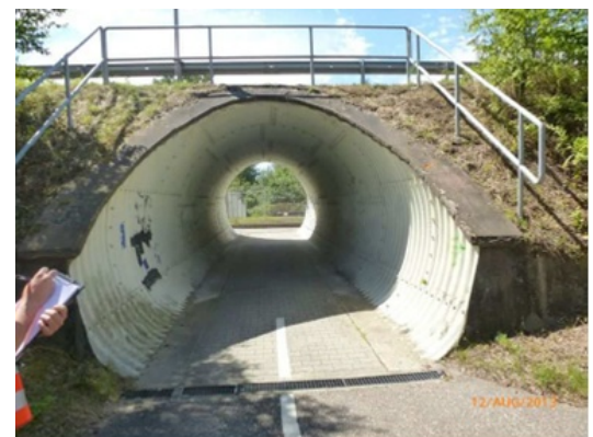
Geh- und Radwegunterführung der K 3574
