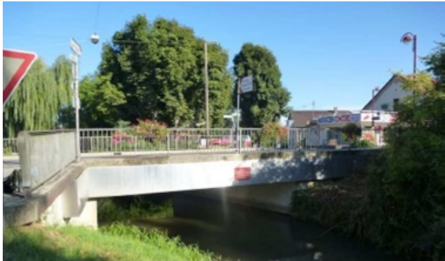
Brücke Karlsruher Straße über die Pfinz
