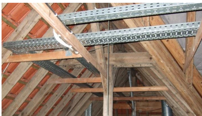
Dachkonstruktion nach der Ertüchtigung
