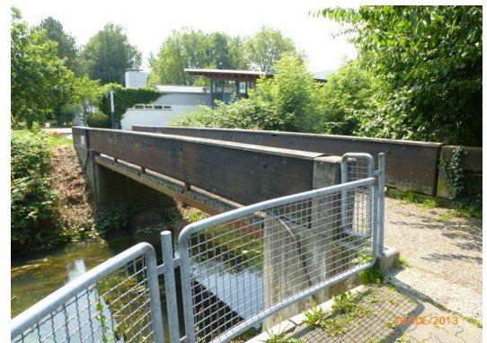
Holz-Trogbrücke über Rheinniederungskanal
