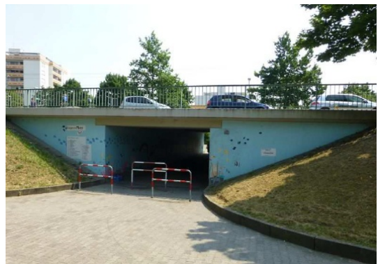
Stahlbetonunterführung an der alten B36
