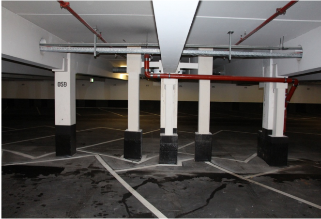
Verstärkungsmaßnahmen nach Fertigstellung
