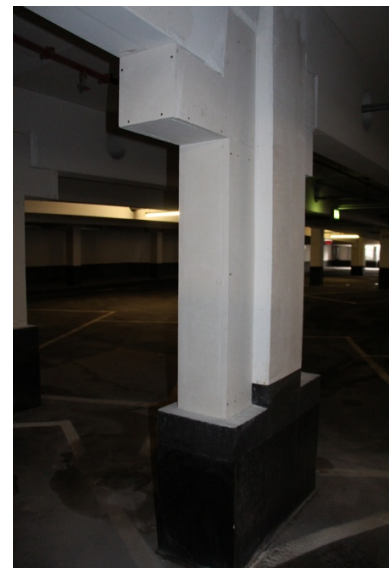
instandgesetzte Konsole
