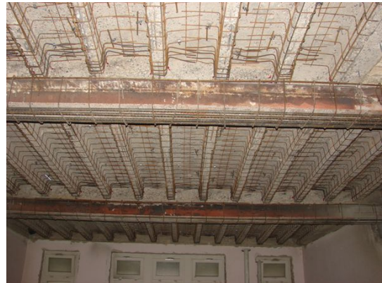
Deckenverstärkung während der Bauphase
