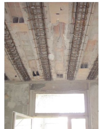
Bewehrung Zwischenräume der Rippendecke
