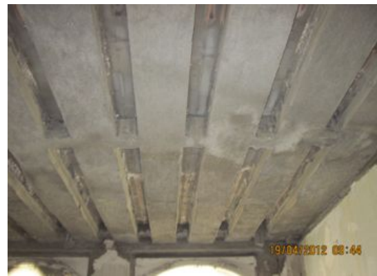
Deckeninstandsetzung Spritzbetonverstärkung
