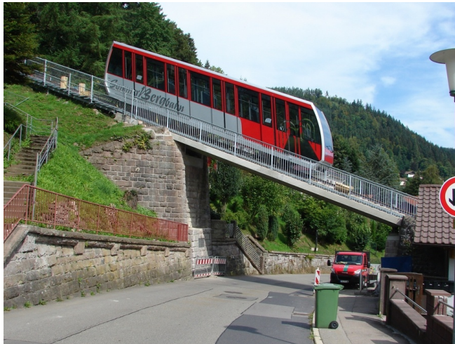
Brücke Bätznerstraße nach Inbetriebnahme
