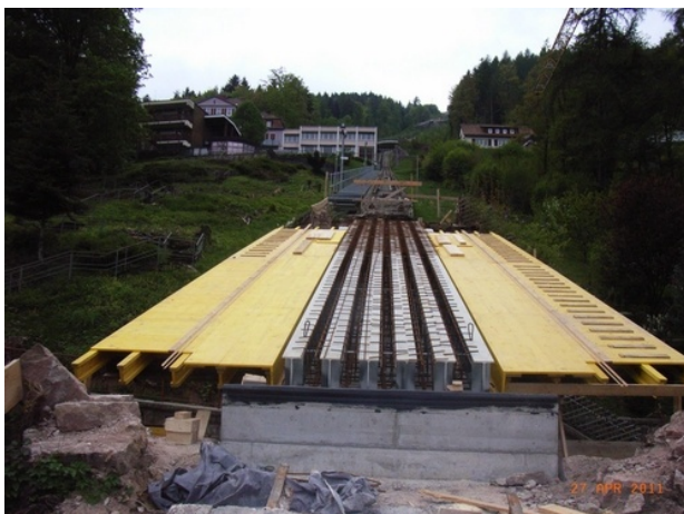
Walzträger-in-Beton-Konstruktion in der Bauphase
