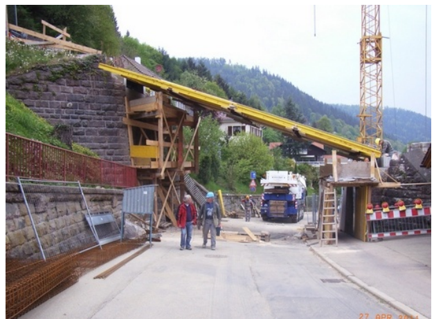
Herstellung des neuen Überbaus
