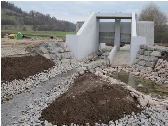
Unterwasseransicht fertiges Auslassbauwerk (beidseitige Dammschüttung fehlt noch)
