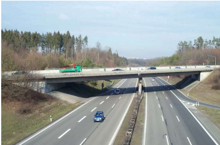
Ansicht der Überführung (A81 untenliegend)
