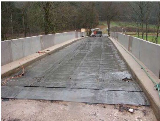
Abdichtung Fahrbahnplatte gem. ZTV-ING, Teil 7
