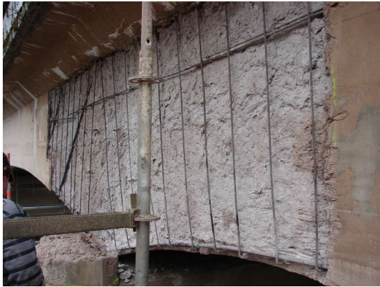
große Schadstelle am Balken mit freiliegender Bewehrung vor der Sanierung bzw. saniert mit Spritzbeton und SPCC-Mörtel sowie Oberflächenschutz OS-C
