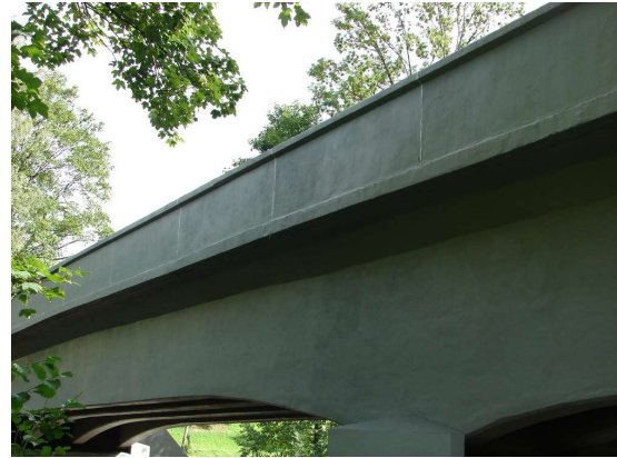
große Schadstelle am Balken mit freiliegender Bewehrung vor der Sanierung bzw. saniert mit Spritzbeton und SPCC-Mörtel sowie Oberflächenschutz OS-C
