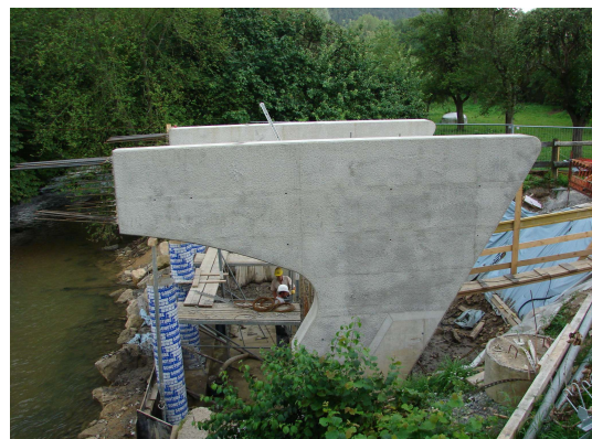
Rahmenecke in der Bauphase
