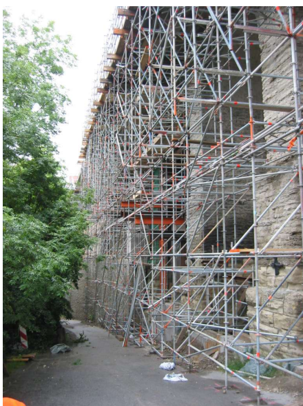
Bauphase: Arbeits- und Traggerüst
