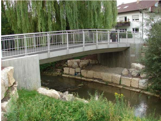
Ansicht fertiges Bauwerk
