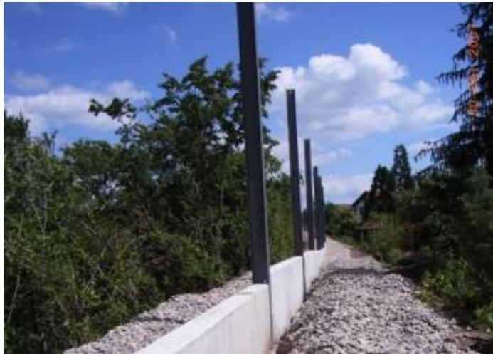
Sockelelement mit Stahlpfosten auf bestehender Walkkrone
