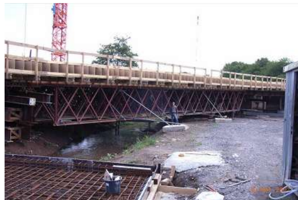
Bauzustand: Traggerüst Mittelfeld
