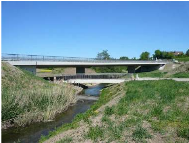
Ansicht BW 10 (davor Fuß- und Radwegbrücke BW 12)
