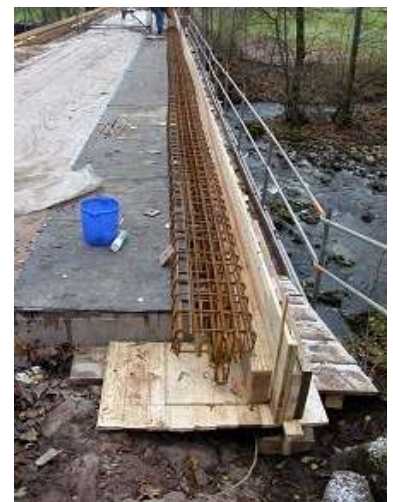
Herstellen neuer Kappe
