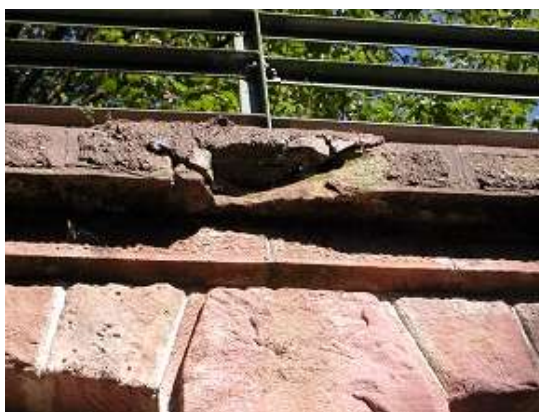
Beschädigte Sandsteinkappe
