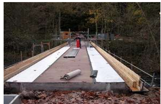
Aufbringen der Brückenabdichtung
