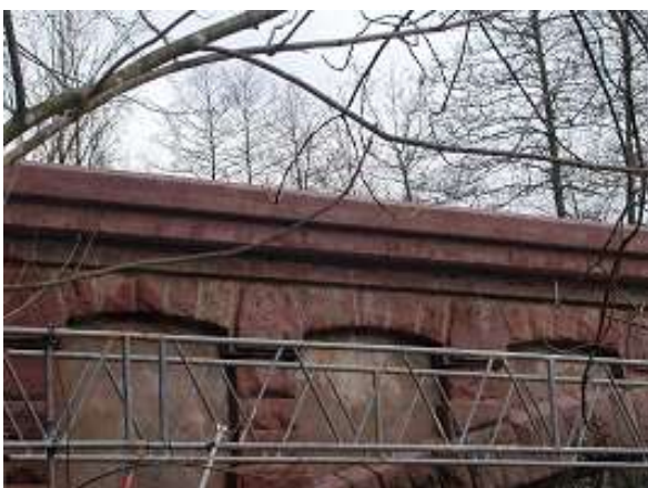
Neue Kappe mit Terramentzement
