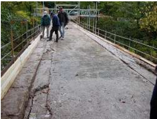
Freigelegter Füllbeton
