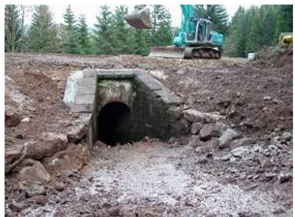
Einlaufbereich nach Instandsetzung
