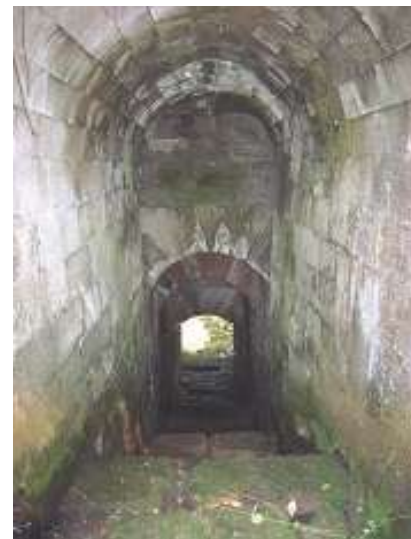
Blick durch Durchlass
