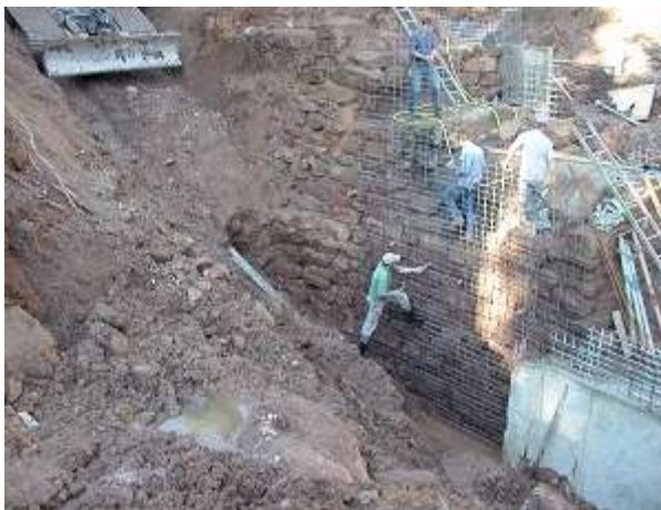
Bewehren des Gewölbebogens
