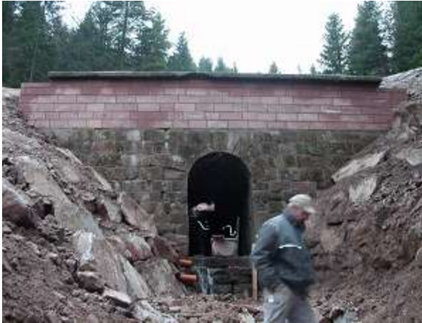
Instandgesetzter Auslaufbereich
