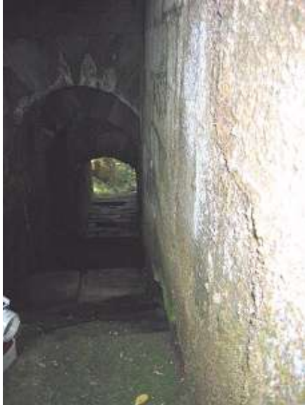
Ausbauchung Widerlagerwand
