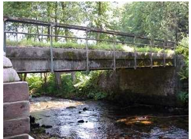
Korrodierte Stahlträger
