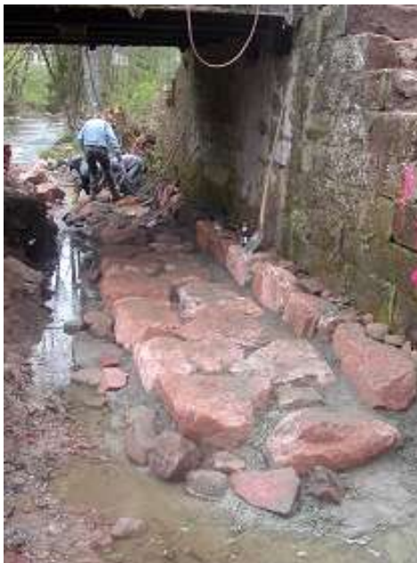
Einbau Kolkschutz
