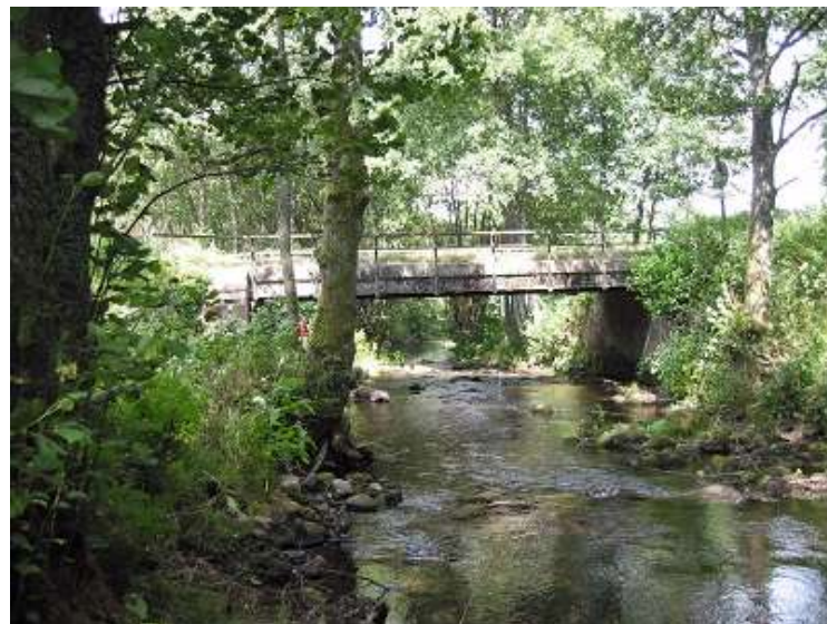
Ansicht Altbestand von "Oberstrom"
