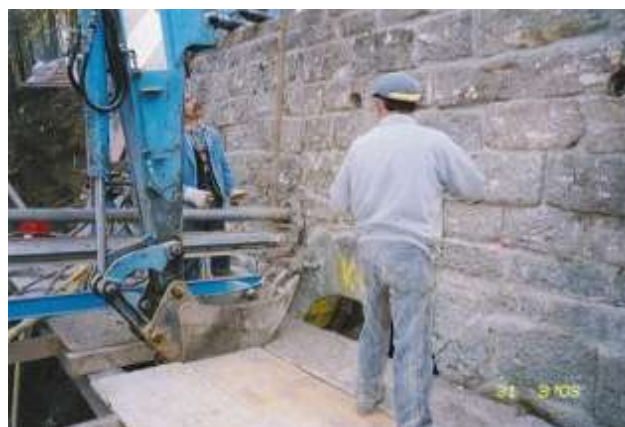
Bohren der Anker
