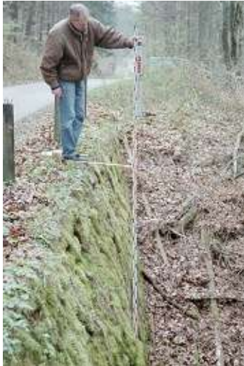
Bauwerksprüfung Bogenscheibe West
