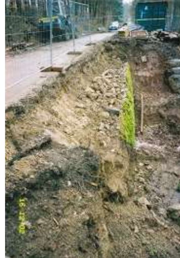
Abbruch Bogenscheibe West
