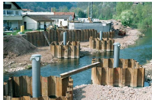
Stahlverbundstützen während der Bauphase
