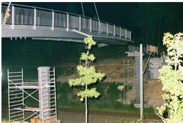
Einheben großes Teil (L = 30,5 m)
