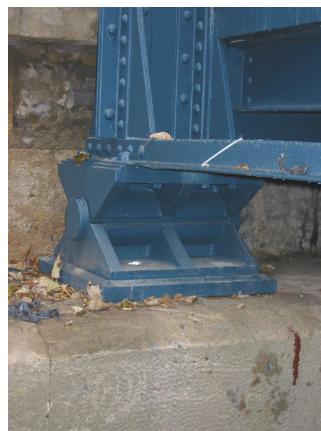
Detail Fachwerk-Knotenpunkt und Lager am Brückenende
